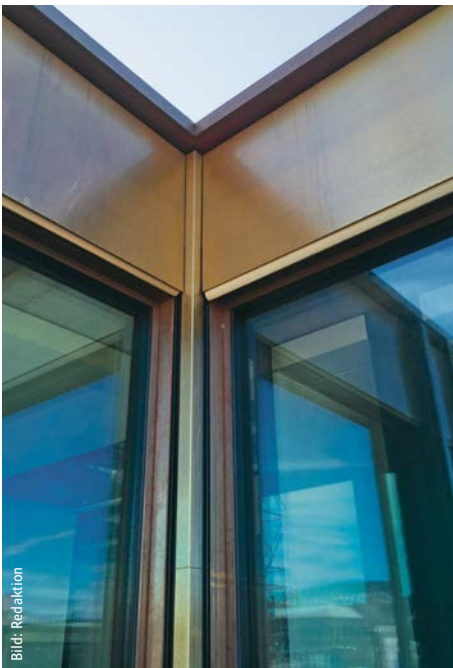
Ausbildung einer Innenecke im Dachgeschoss. Im Bereich der Glaskante sind auch die Horizontalstäbe der Beschattungsmarkise zu erkennen. Angle intérieur au dernier étage. Les barres horizontales des stores d'ombrage se trouvent au niveau de l'arête du verre.
