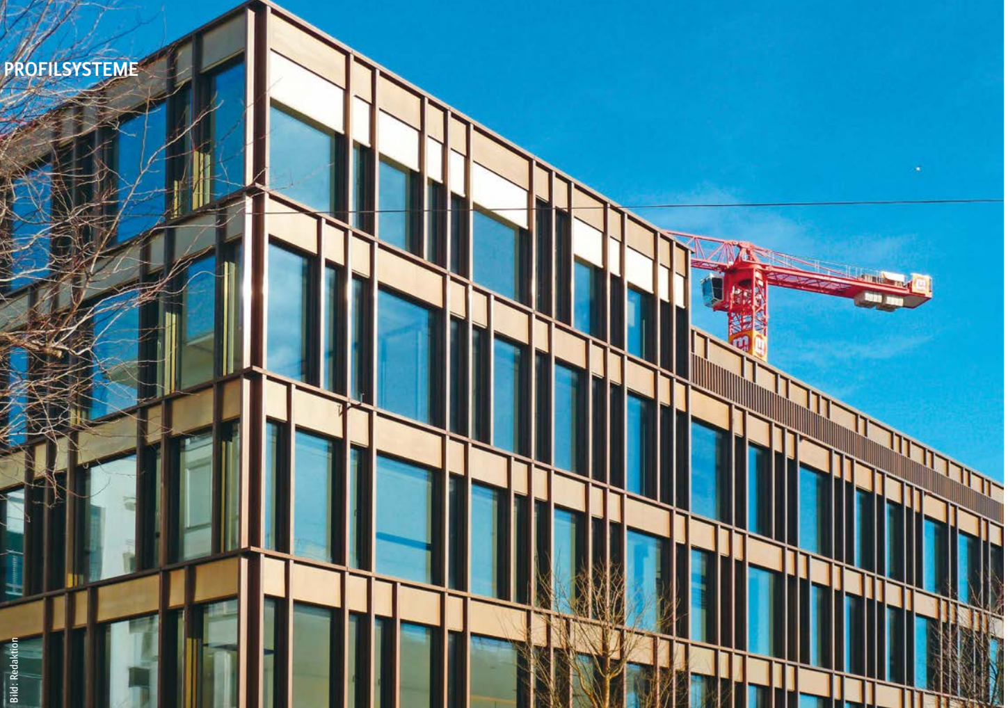
Für das Geschäftshaus wurden neun verschiedene Bronzeprofile mit einem Gewicht von insgesamt 120 Tonnen hergestellt. Neuf profilés en bronze différents d'un poids total de 120 t ont été fabriqués pour l'immeuble commercial.
