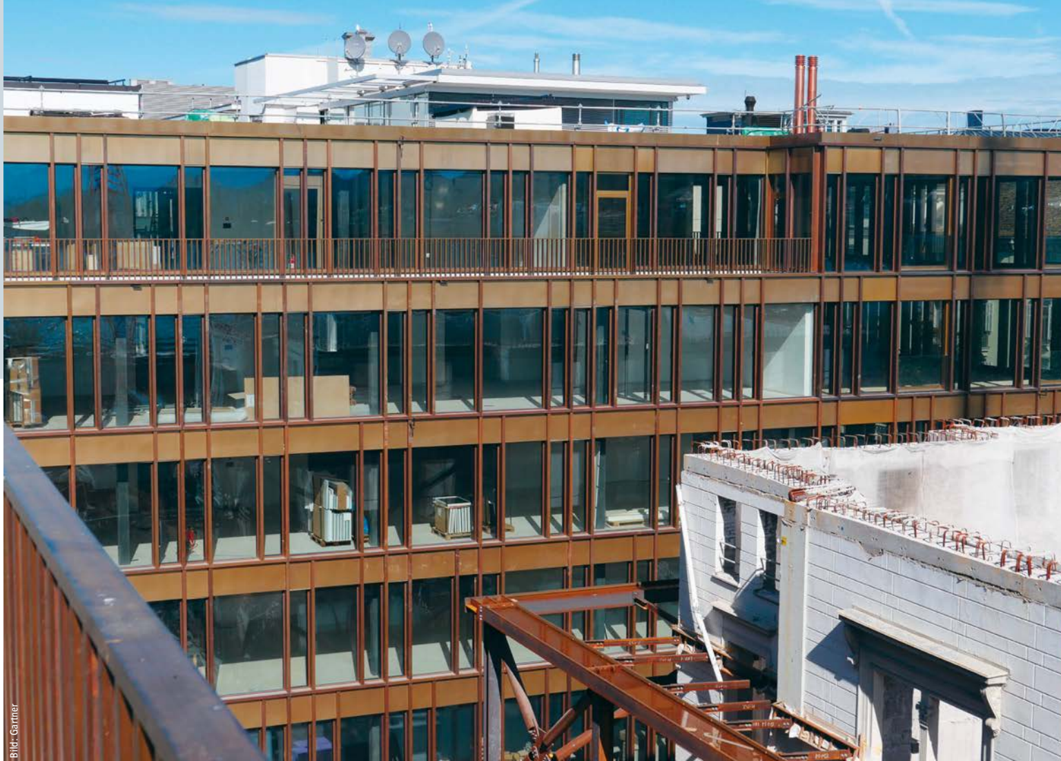
Die Aluminium-Elementfassade ist durch die äusseren Applikationen in Baubronze nicht als solche zu erkennen. La façade modulaire en aluminium n'est pas identifiable comme telle en raison des applications extérieures en bronze de construction.
