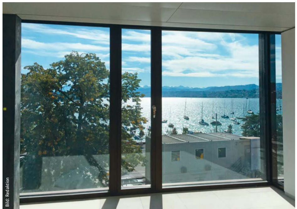
Das leistungsstark beschichtete Glas erreicht eine Lichttransmission von 65 Prozent und einen g-Wert von 35 Prozent.
